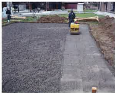
1 碎石を1t振動ローラーで8走行し転圧
