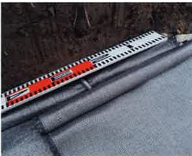
4 施工図に従い重ね巾を確認
