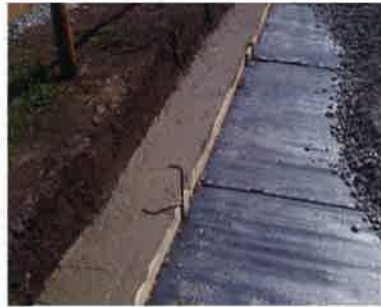
5 コンクリートで端部固定
